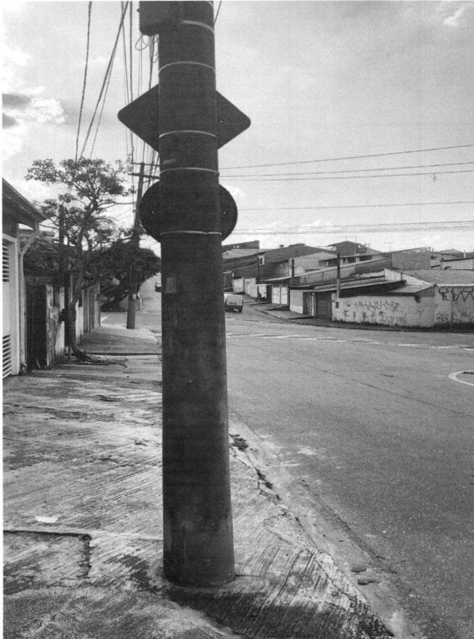
IMPLANTAÇÃO DE PLACA DE SINALIZAÇÃO DE MÃO ÚNICA NA RUA SHOZO SAKAI Nº154, CONJUNTO RESIDENCIAL BOSQUE – MOGI DAS CRUZES
